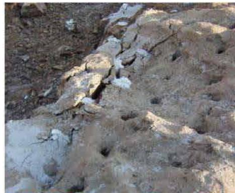
C. A argamassa **Splitstar®** deve encher os buracos em rocha ou concreto. A força expansiva pode quebrar as rochas ou o concreto em 2 a 8 horas.
